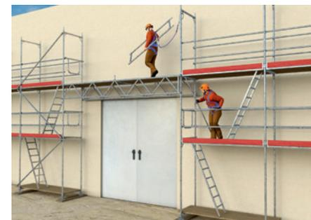
Abbildung 53 - Achtung: Angaben zu den zulässigen Anschlagpunkten sind der Verwendungsanleitung des Gerütherstellers zu entnehmen
