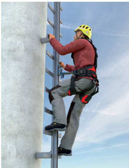
Figure 49 - Schéma d'un système mobile EN 353-1 incluant un support d'assurage rigide
