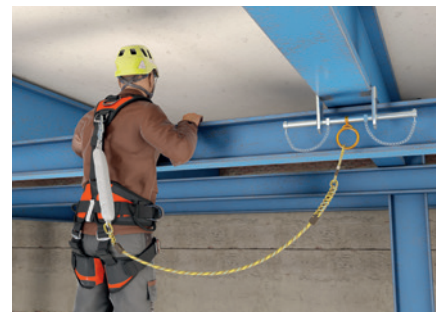
Figure 52 - Schéma du système avec absorbeur d'énergie EN 355
