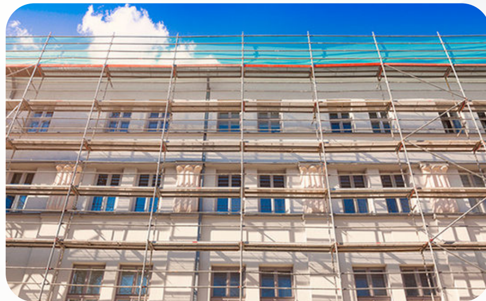
ECHAFAUDAGES DE PIED
