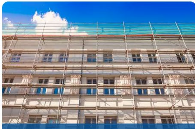
Echafaudages de pied
