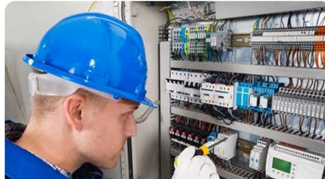
Préparation à l'habilitation électrique
