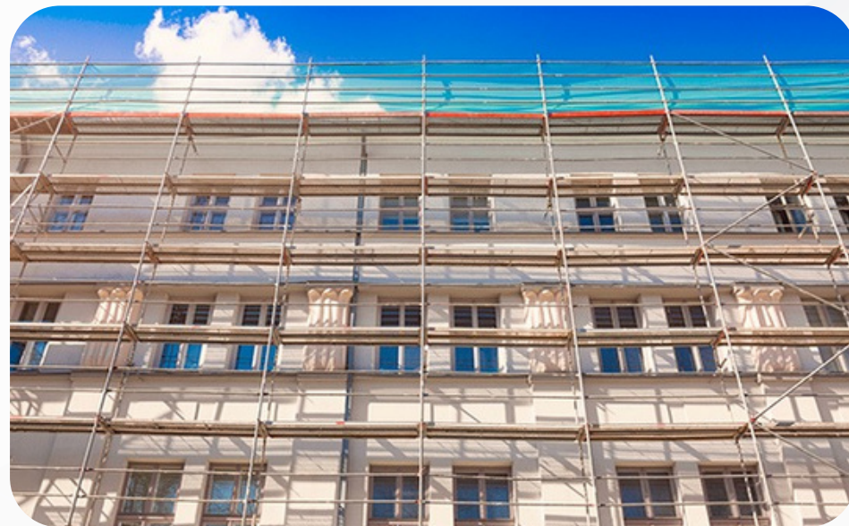
ECHAFAUDAGES DE PIED
