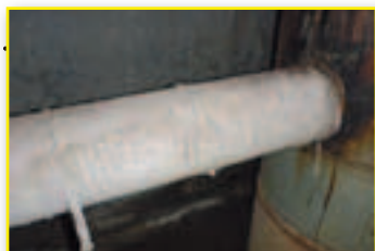
Enrobage de tuyaux
