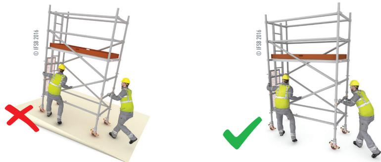
Bloquer les roues à l'aide des freins avant de monter sur l'échafaudage roulant !
