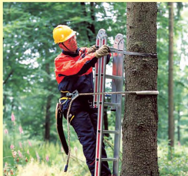
**Attention :** les travaux de tronçonnage ne peuvent être réalisés à partir d'échelles qu'à condition de pouvoir guider la tronçonneuse à deux mains. Utiliser un harnais de maintien au travail.
