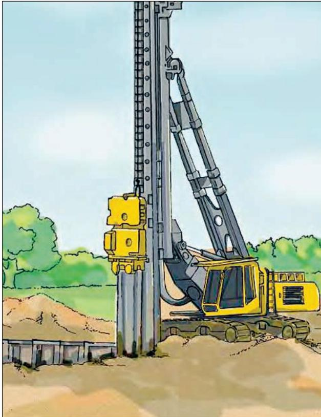
Rammen werden im Spezialtiefbau eingesetzt, um Rammelemente (z. B. Stahlprofile, Beton-Fertigteile) durch Schlagen, Rütteln oder Pressen in den Baugrund einzubringen oder aus dem Baugrund zu ziehen.
